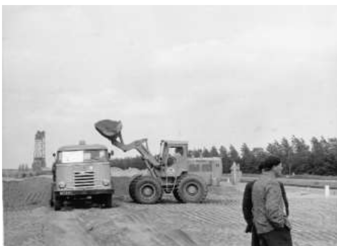
Foto 8 Nadat de RTM tramverbinding is opgeheven werd de rails verwijderd en de kruising van de trambaan met de Groene Kruisweg aangepast.
